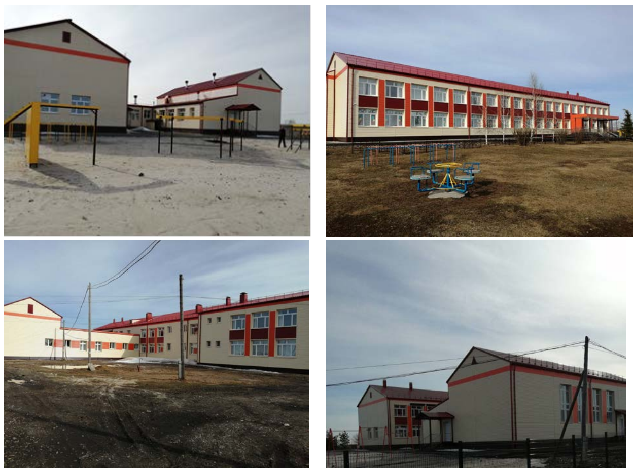
Рисунок 5. Здание с. Калмакское, ул. Новая, д 1
